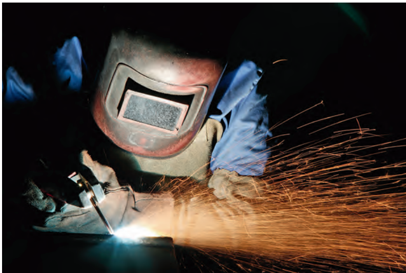
Reparation av skada på cistern
