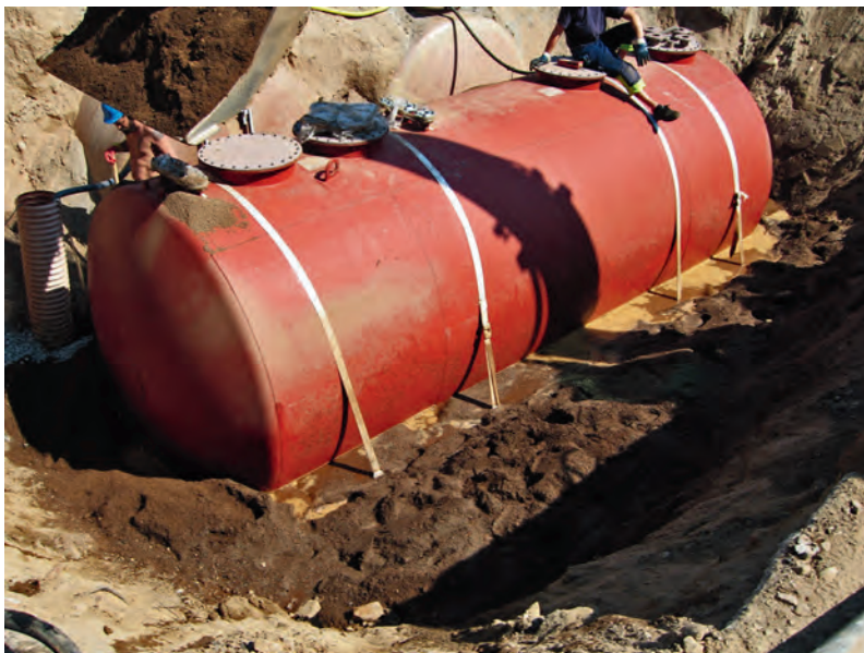
Cistern förbereds för installationskontroll
