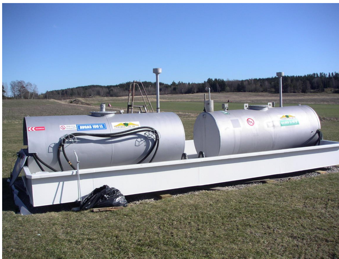
Trosa flygplats. Enkel tankstation för blyad flygbensin om 3.000 liter och oblyad flygbensin om 3.000 liter. Anläggningarna har handpump, då det inte finns någon elektricitet på flygfältet. Detta minimerar också investeringskostnaden.
